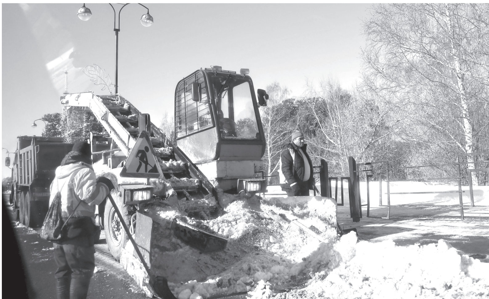
Дорожники трудятся на улице Ремезова
