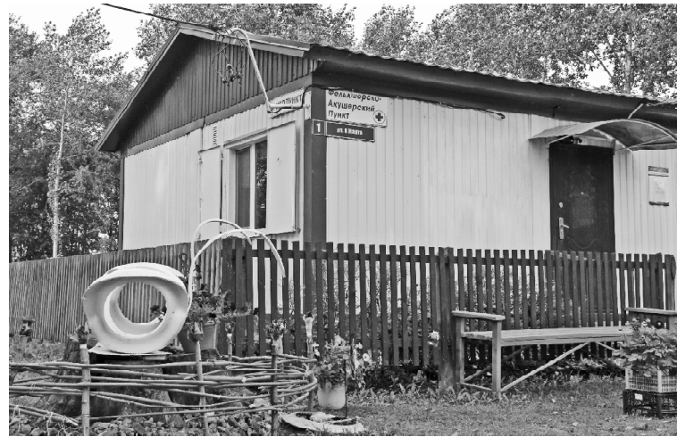
➤ Благоустроили территорию ФАПа // Фото автора
