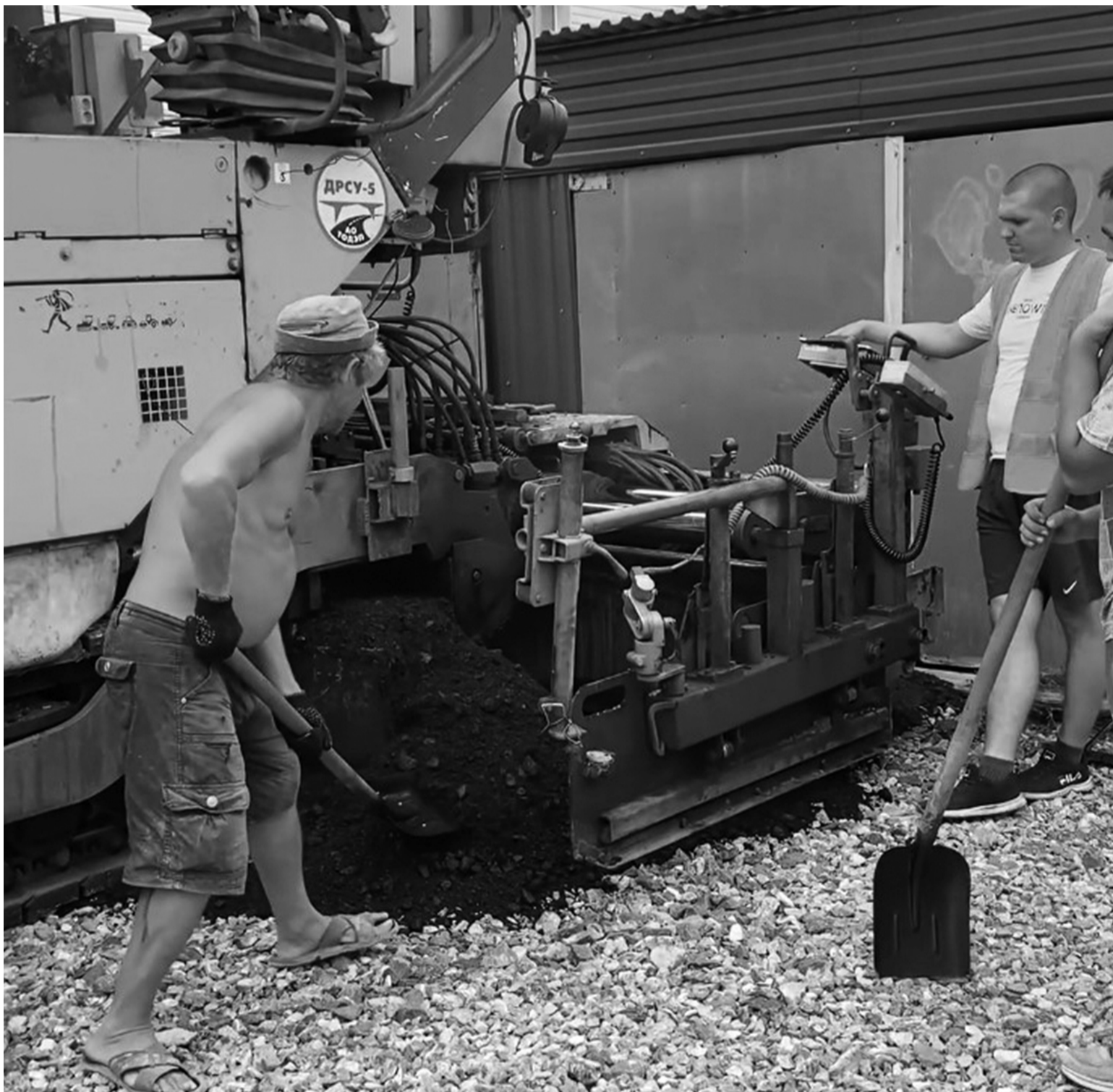
Рабочие ведут укладку асфальта
