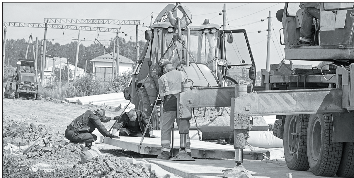
Укладка плит – процесс трудоёмкий
