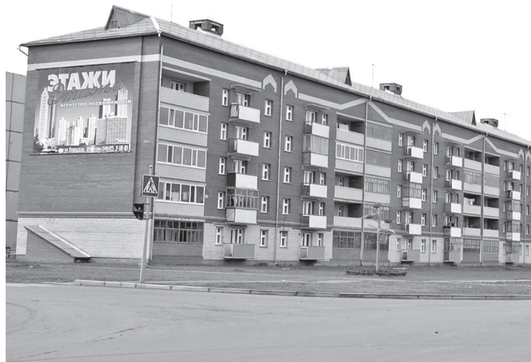
• С июня начнётся сбор средств на капитальный ремонт многоквартирных домов.
