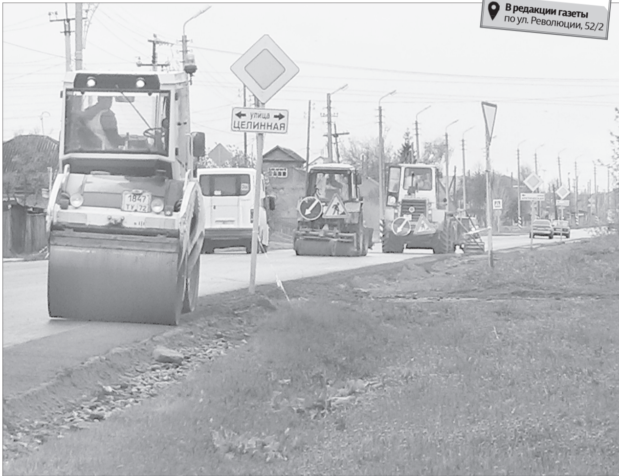
Из-за ремонта дорожной «одежды» полотно Комсомольской возвысилось над соседними улицами, но вскоре эти перепады будут устранены /ФОТО АВТОРА
