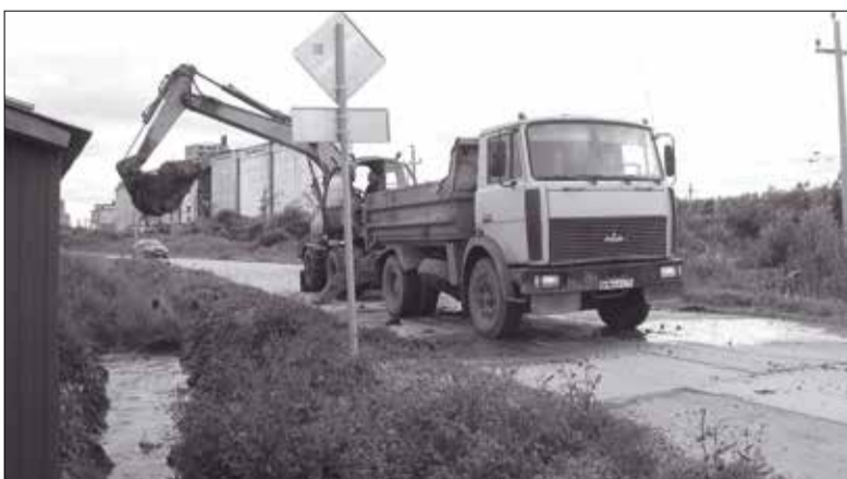
На водоотведении заняты две единицы техники – экскаватор и самосвал
