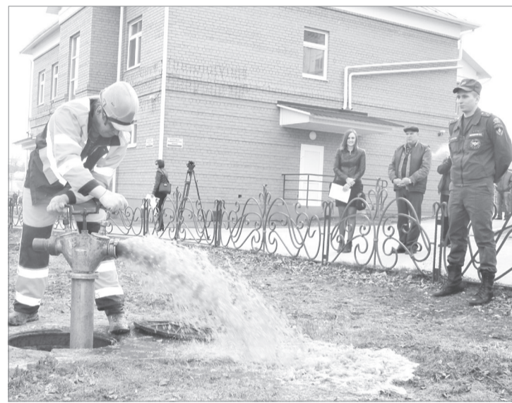
Сотрудники «Горводоканала» и пожарной части проверяют работу пожарного гидранта
