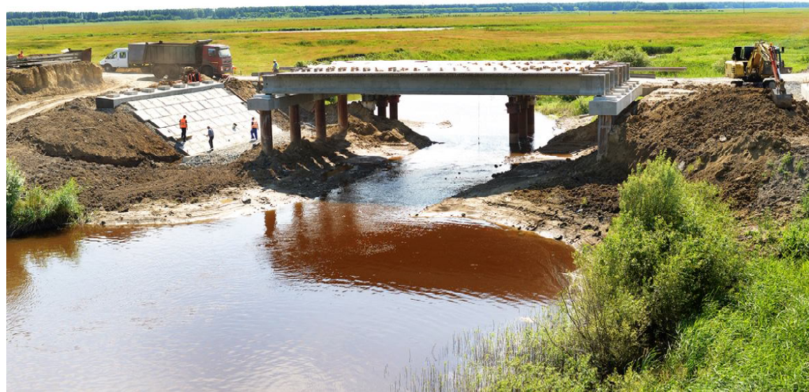
Идет монтаж пролета моста на реке Вагай
