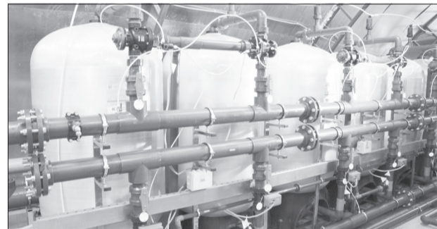
Система смягчения воды на станции обезжелезивания уже работает
