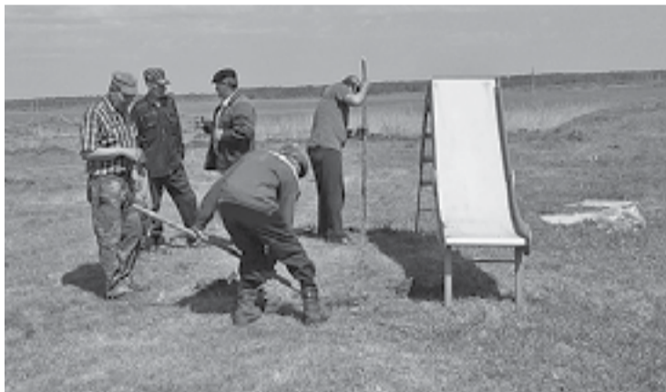
* Монтаж игрового оборудования в Малом Куртале. Вот радости будет для ребят!
