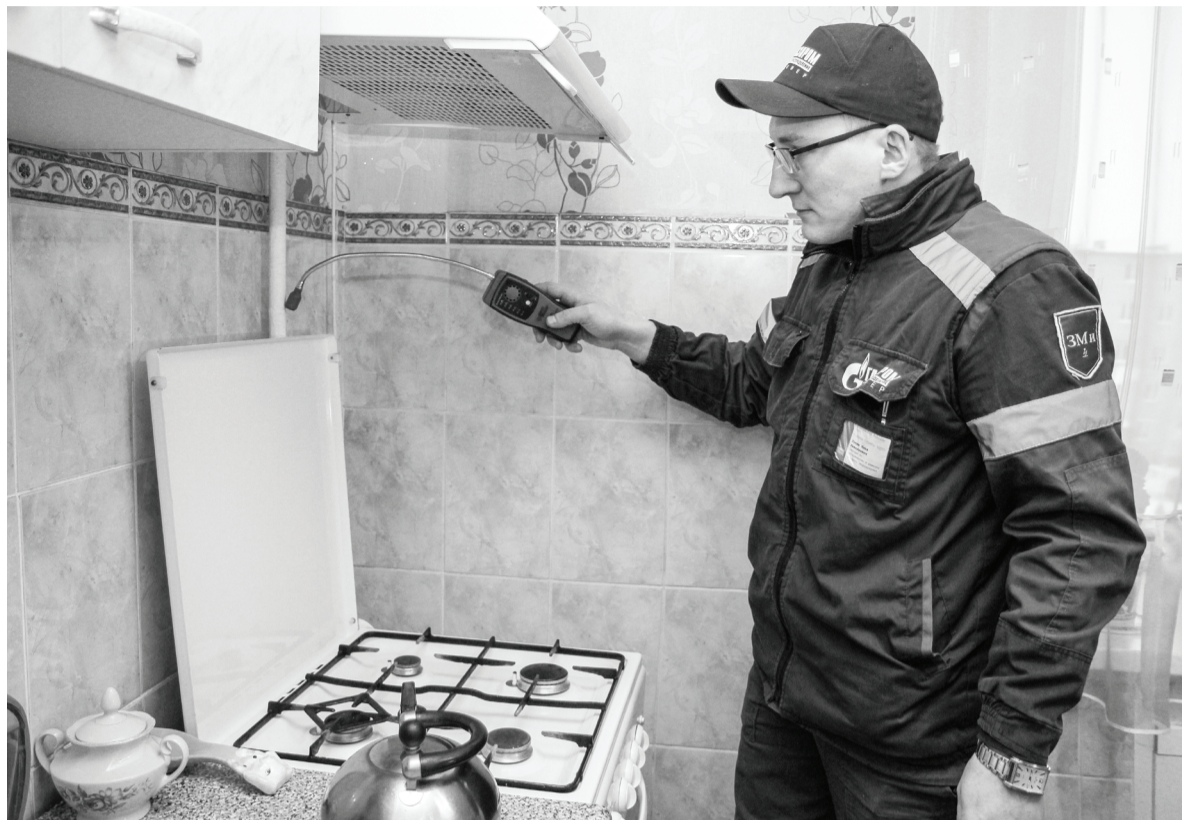
Слесарь восточного треста «Газпром газораспределение Север» Илья Гусев проводит техническое обслуживание газового оборудования – плиты: проверяет исправность кранов, форсунок, системы вентилирования. // Фото Василия БАРАНОВА.
