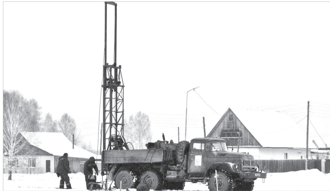
• Пока на территории новой школы работает буровая установка.
