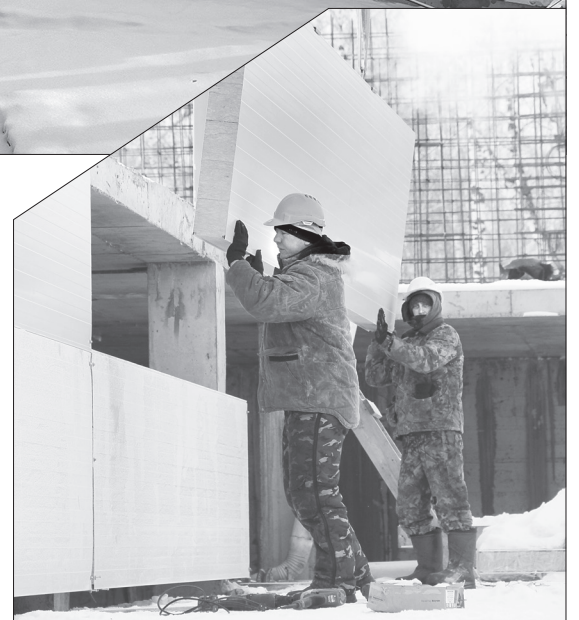
Внешнюю сторону здания обшивают сэндвич-панелями с утеплителем
