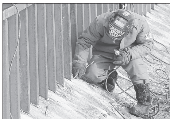
Идёт монтаж металлоконструкций чаши бассейна
