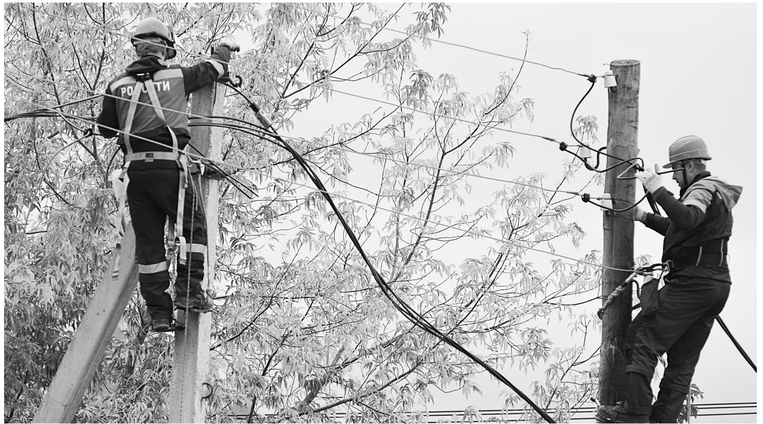
Сотрудники Нижнетавдинских электрических сетей продолжают ремонт и обслуживание своего хозяйства.
