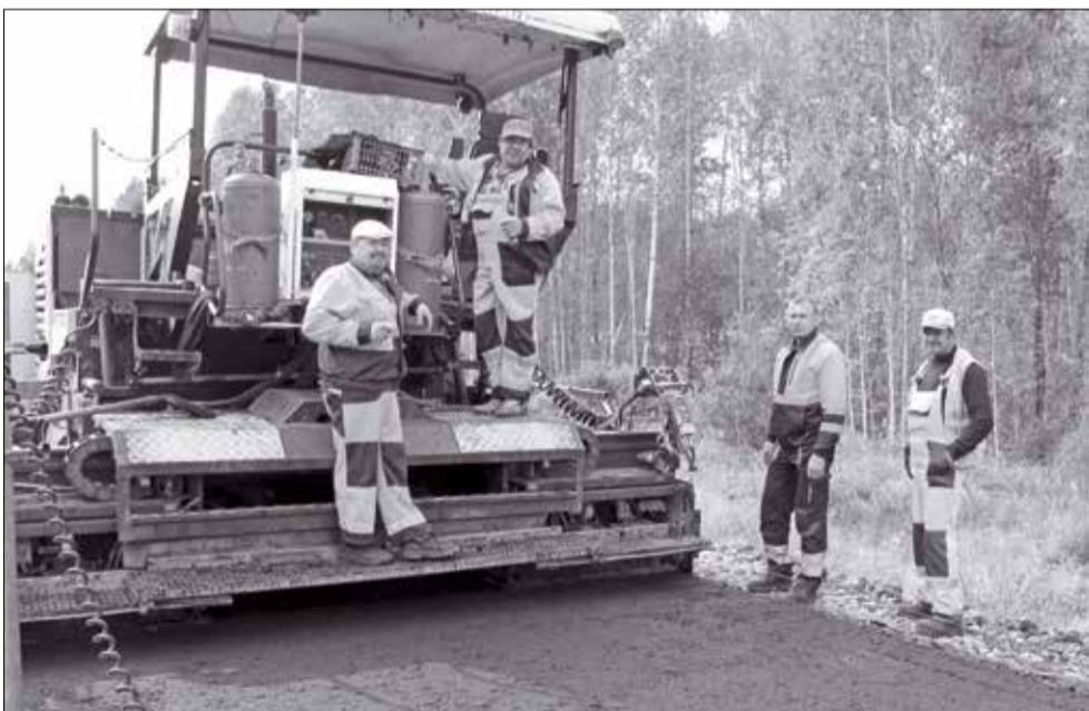
Ровно ложатся усилиями дорожников ДРСУ-4 метры свежего асфальта на участке автодороги Голышманово – Аромашево
