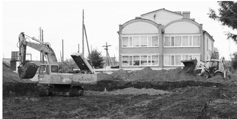
По улице Ленина идёт подготовка к закладке фундамента под многоквартирные дома.
