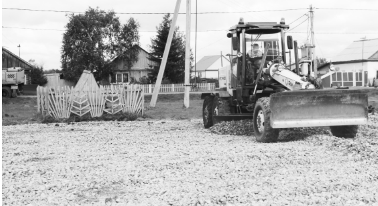
Возле школы строят площадку.
