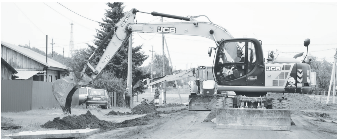
Пока земля не просохла после дождей, на улице Чехова в с. Упорово дорожники углубляют водосточные каналы.
