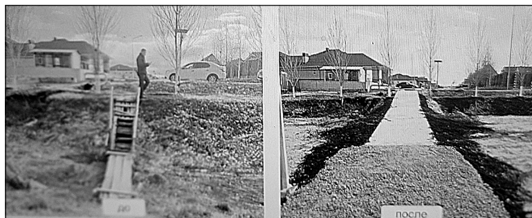
Устройство пешеходной дорожки по ул. Виноградная с. Кулаково по Ирбитскому тракту.
