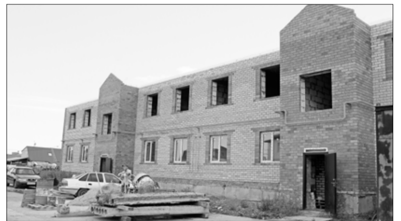
В полном разгаре строительство жилого дома в переулке Железнодорожном
