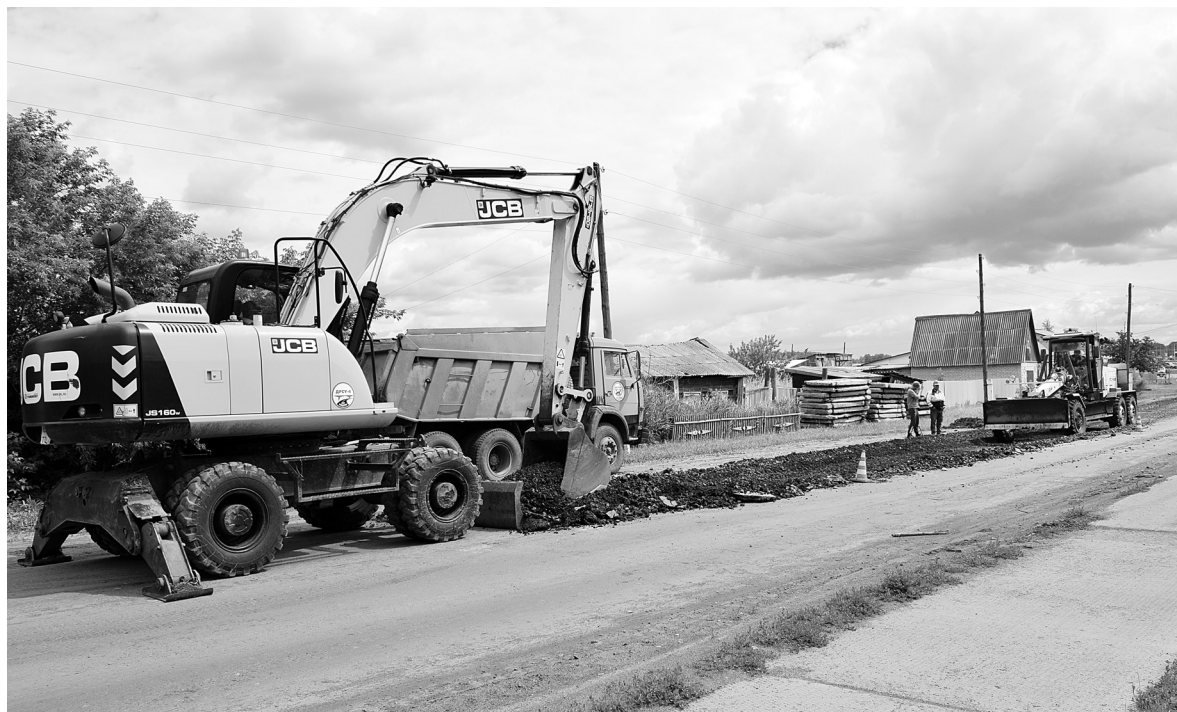
Идет ремонт улицы Кирова в Бердюжье
