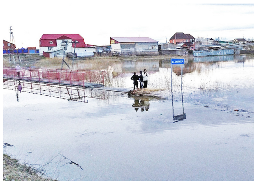
Пешеходный мост через реку Зимиху скрылся под водой 18 апреля
