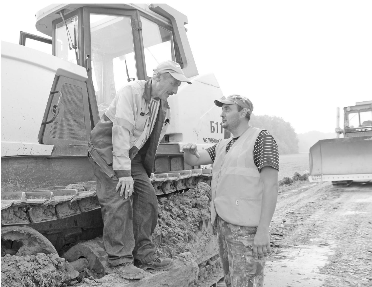
Прораб Нижнетавдинского ДРСУ А.Гуммер в ходе работ обсуждает профилировку земляного полотна с бульдозеристом.
