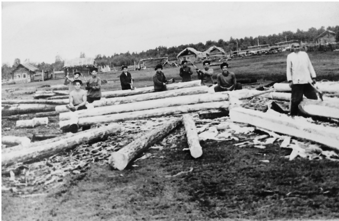
Переселенцы за строительством домов в деревне Малые Юрты.
