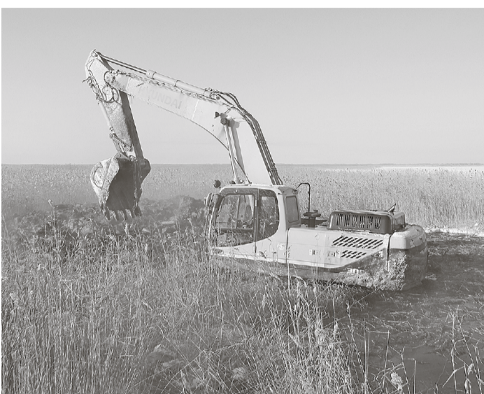
* На оз.Дедюхино идут масштабные работы по очистке даже в условиях сибирских морозов.
