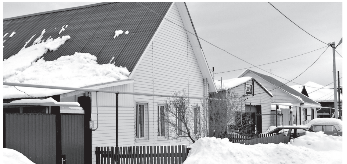
• На улице Школьной в Заводоуковске газопровод тоже проводили на деньги жителей. Цена вопроса зависела от числа желающих завести газ в дом: чем их больше, тем стоимость работы дешевле.
