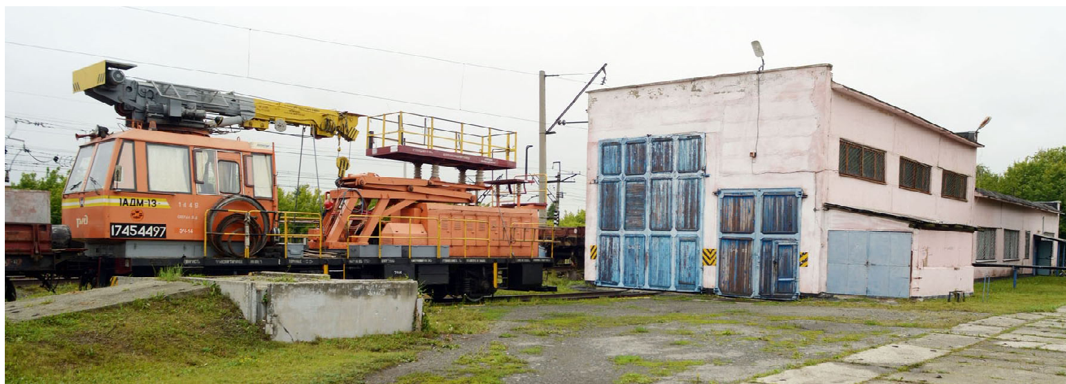
Рабочая территория дежурного участка контактной сети
