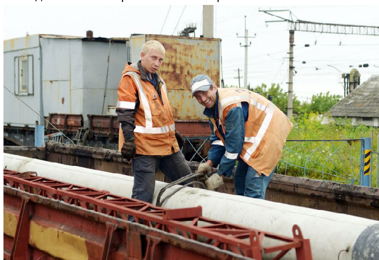
Электромонтеры В.Г.Борисов (слева) и М.С.Хатестов готовят оборудование для ремонта
