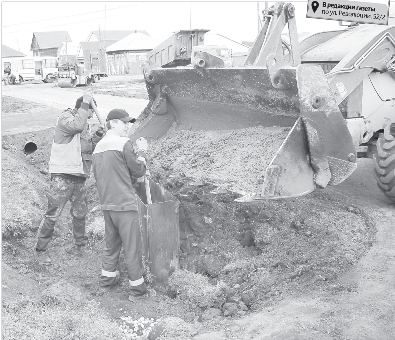
Работы по обустройству дорожного полотна улицы Мира в Аслане завершились заливкой оголовников водопропускных труб большого диаметра /ФОТО АВТОРА
