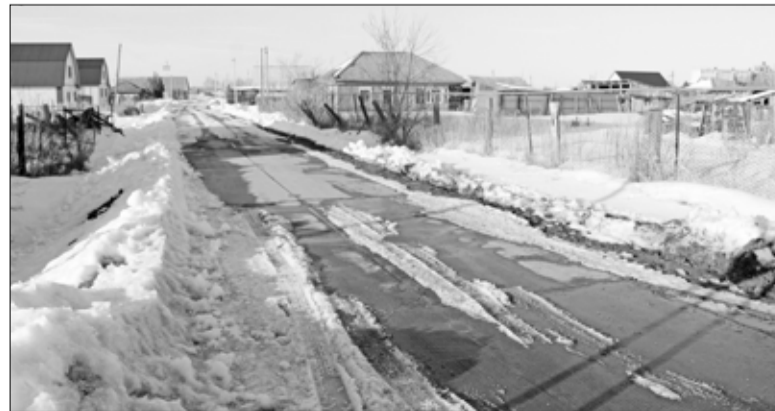
Дорога в переулке Омском нынешней весной уже не будет «головной болью» жителей
