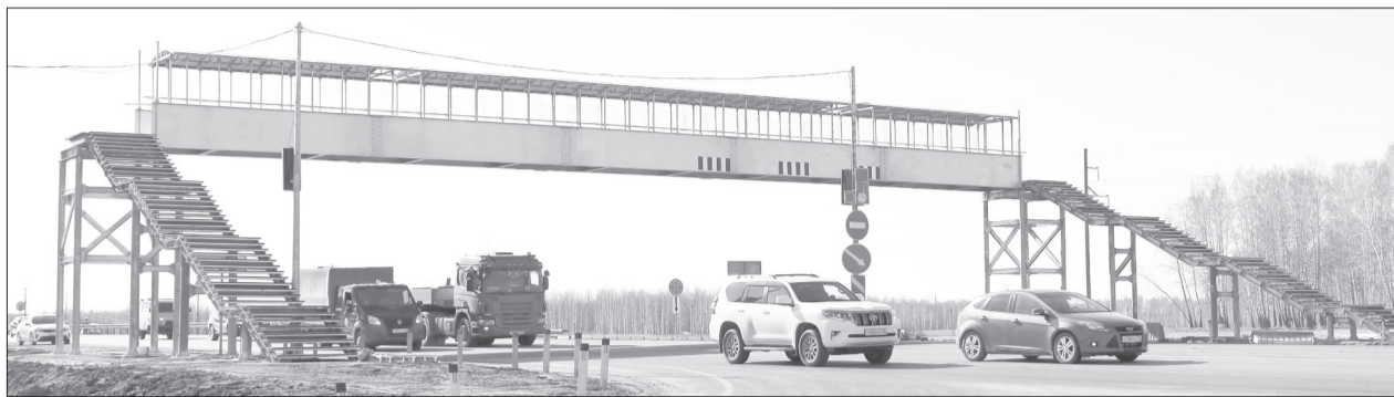
Строительство надземных пешеходных переходов в районе Беркута и Киёво началось в ночь на 1 апреля /ФОТО АЛЕКСАНДРА СМЕРНОВА
