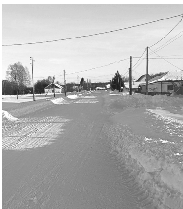
Обследование дорог на Ламенской территории пройдёт сразу после схода снега
