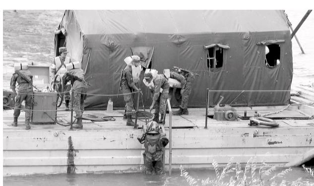
срок восстановить прерванное движение. Техническая разведка и водолазное отделение провели обследование разрушений мостовых конструкций – как наземной, так и подводной его частей. Был заменён один из пролётов моста. Кроме того, служащие железнодорожных войск продемонстрировали операцию по сооружению так называемого ложного
