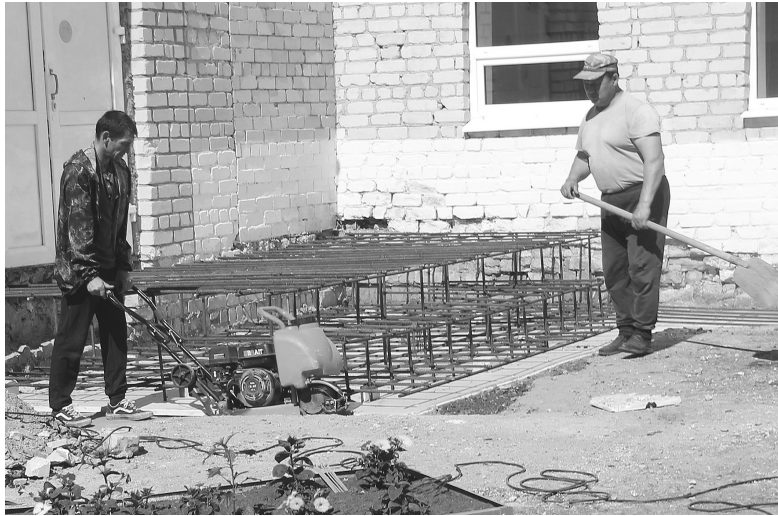
Рабочие ИП Петрова подготовили опалубочную конструкцию для заливки нового крыльца из бетона у центрального входа Голышмановской сельской школы
