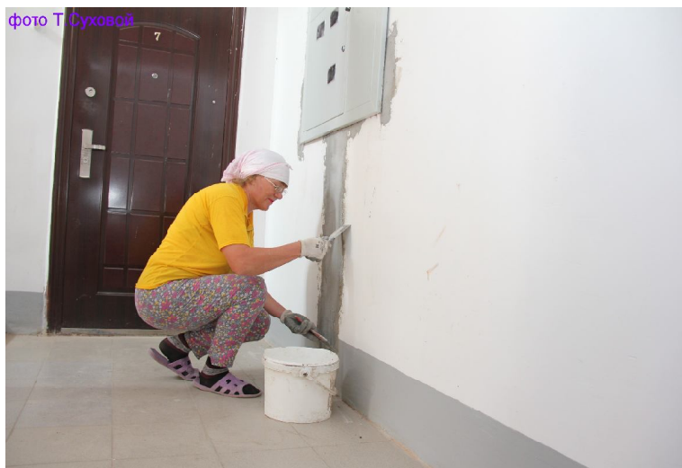
▶ В подъезде дома по ул. Кузнецова.
