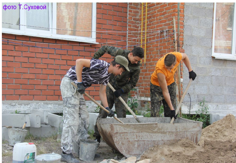
▶ Подготовка раствора по ул. Чапаева.
