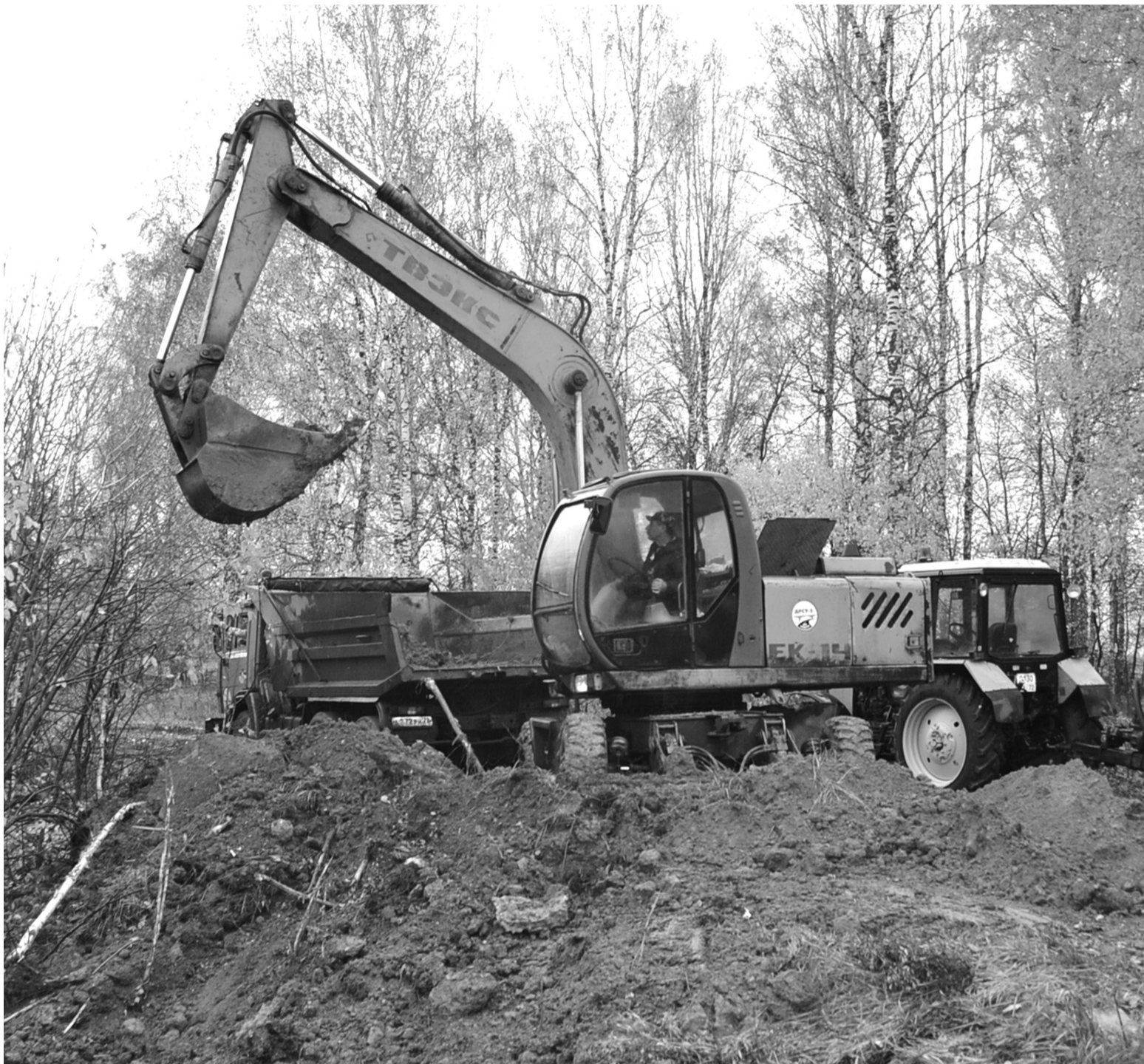
В селе Готопутово даже в дождь ведутся работы по замене и укреплению водоперепускной трубы
