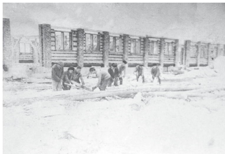
Идет строительство животноводческой фермы
