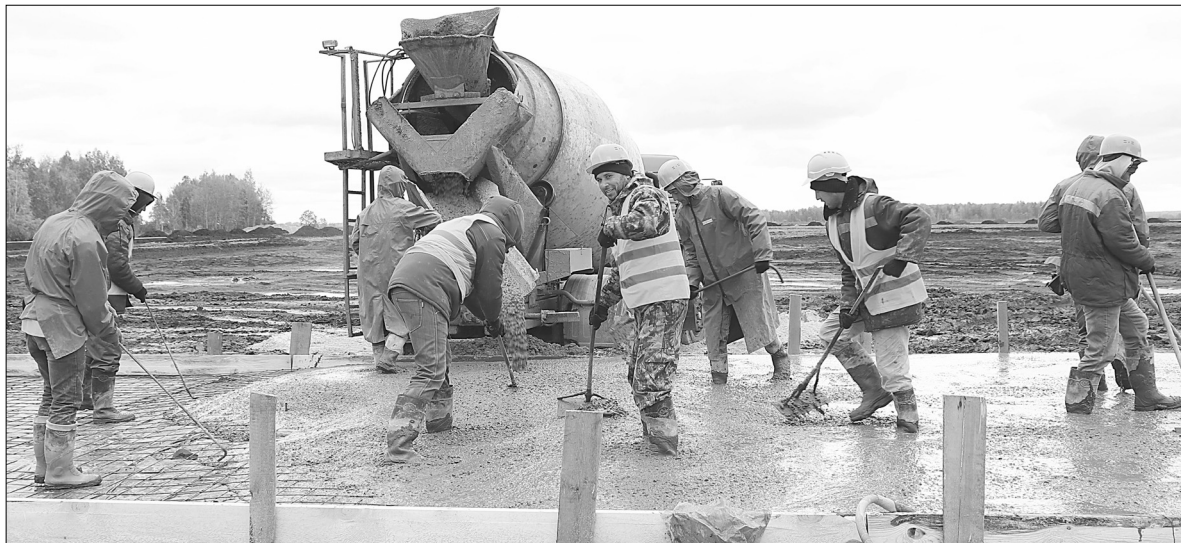
Рабочие заливают бетоном парковку площадью 4000 квадратных метров
