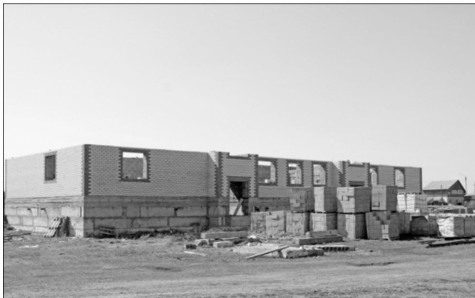
Стройка начата на улице Островского
