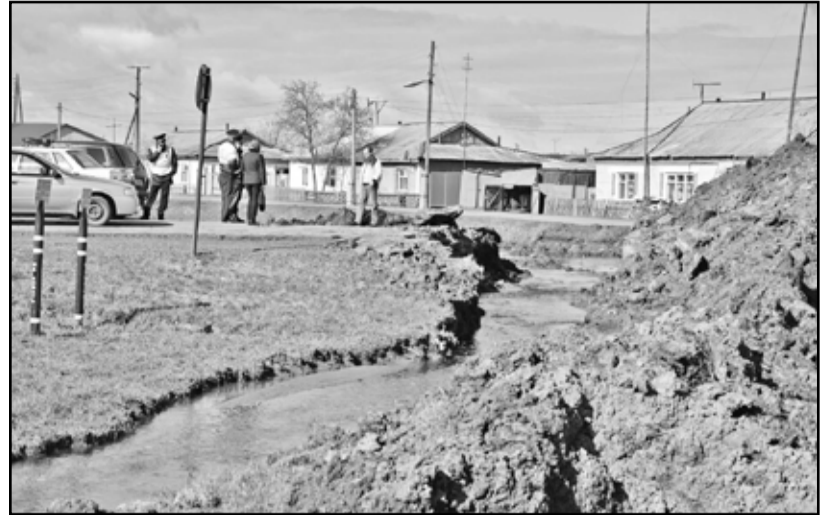
Траншею вырыли. Вода уходит
