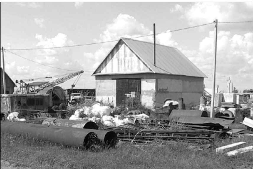
Такой беспорядок на строительном участке на улице Молодых
