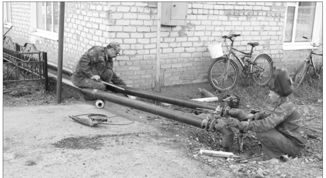
Сварщик Виктор Сaitов и слесарь Владимир Молодцов производят врезку жилого дома в основную теплотрассу
