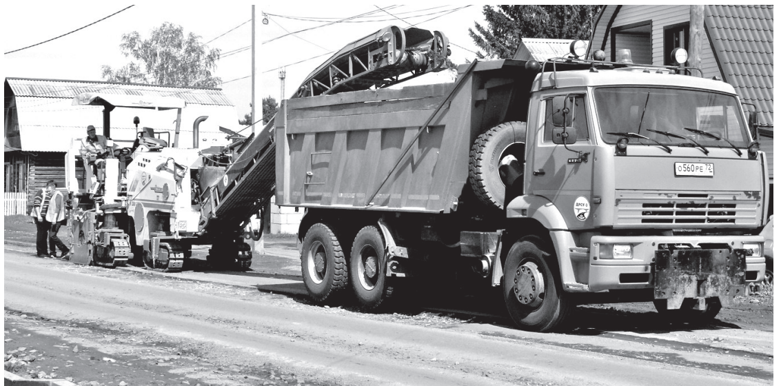
• Дорожники фрезой срезают изношенное асфальтовое покрытие, которое позднее заменят на новое. И старому асфальту тоже найдут применение.
