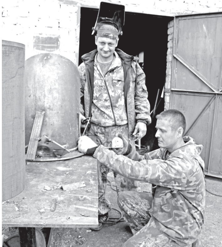
• Слесари Заводоуковского элеватора Владимир Предеин и Андрей Урих готовят узлы для замены нории – ковшового погрузчика, который был изготовлен много десятков лет назад. Чертежей на агрегат уже нет, поэтому рабочие сами всё измеряют, режут, сваривают и монтируют.
