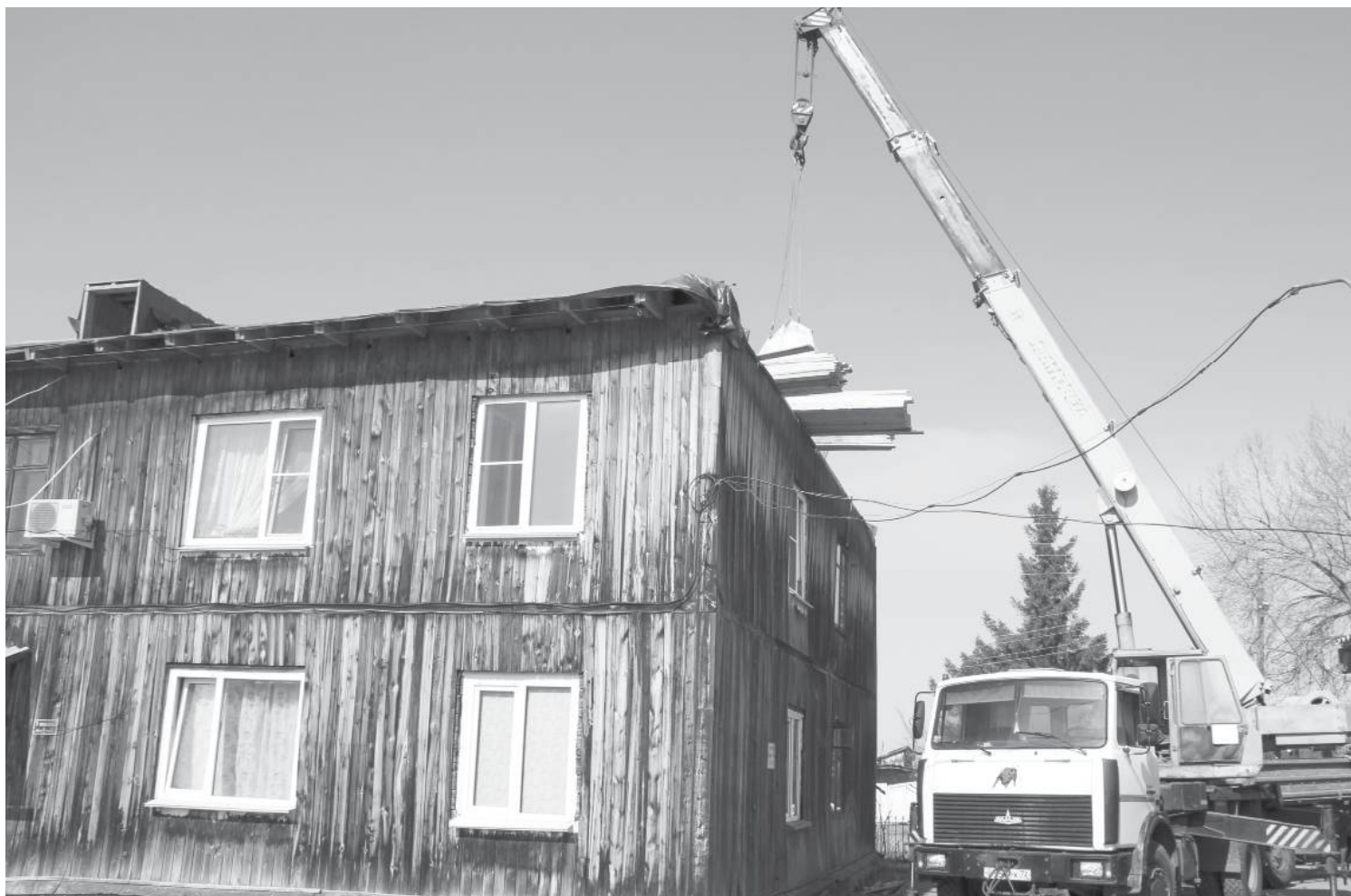
На улицах Сладкова, Маслянки и Майки идёт ремонт многоквартирных домов.
