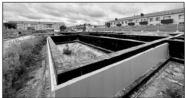
На будущей поликлинике – этап закладки фундамента.
