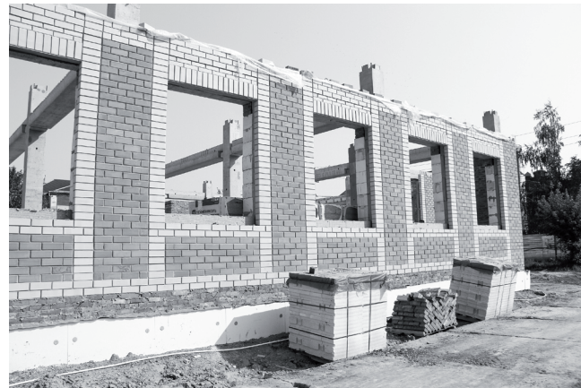
Здание МФЦ растёт уверенными темпами: уже выполнена кладка первого этажа, строители перешли к монтажу перекрытий и строительству стен второго этажа. // Фото Василия БАРАНОВА.
