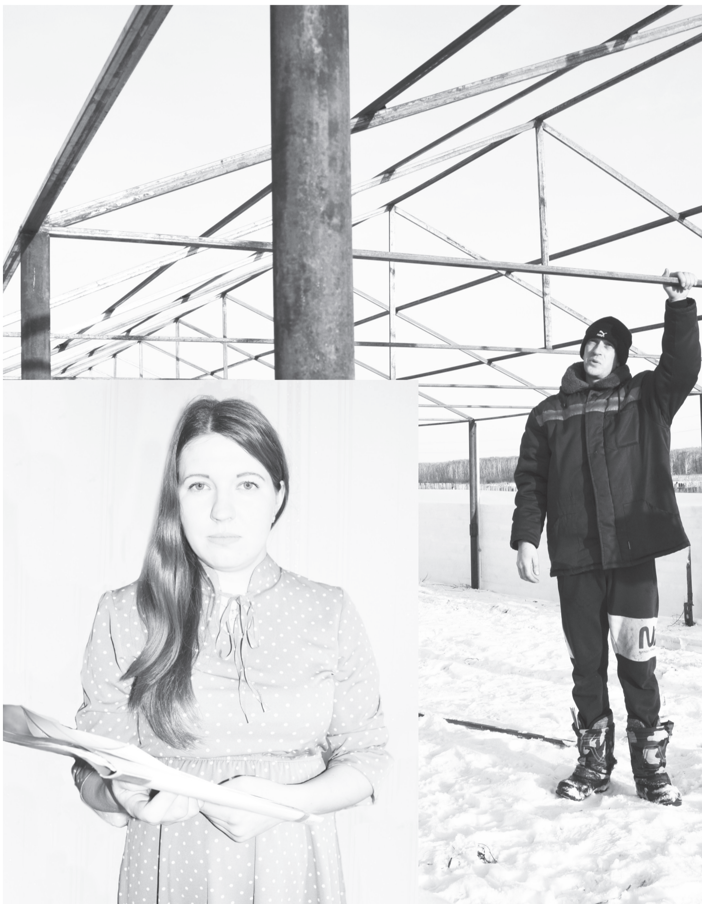
Строительство теплицы площадью 160 квадратных метров идёт полным ходом.
