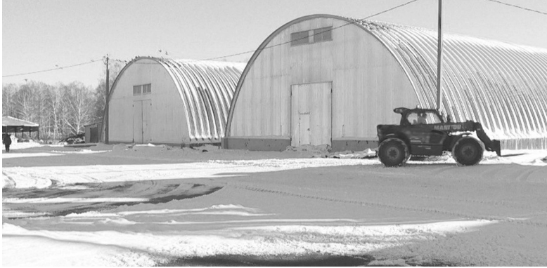
Склады на зернотоке в Гладилово полностью заполнены зерном
