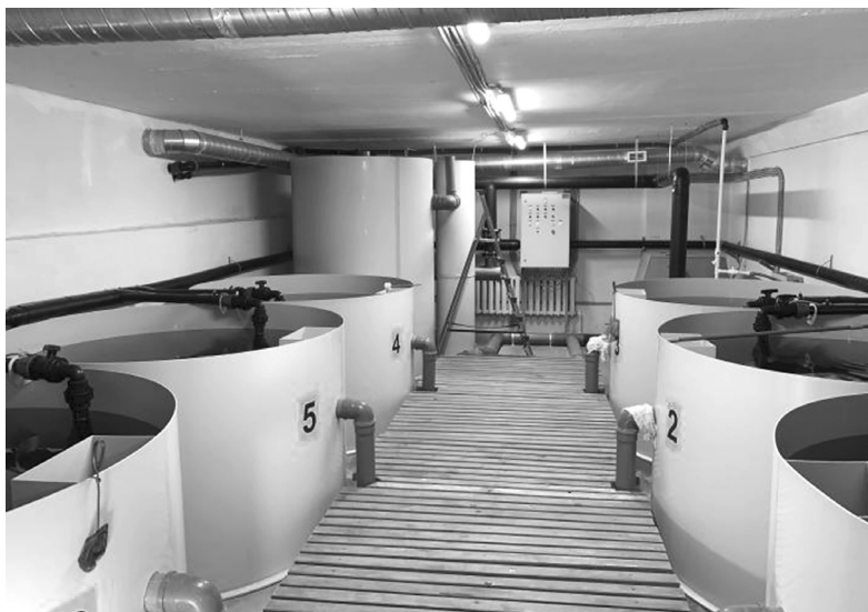
«Рыбное подворье» – автоматизированная современная ферма с цехом водоподготовки. Вода проходит шесть ступеней очистки перед подачей в бассейн
