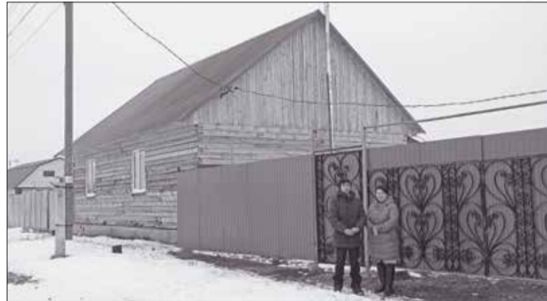
Благодаря помощи неравнодушных людей Отыншиновы за полгода смогли построить новый дом и надворные постройки на месте бывшего пепелища
